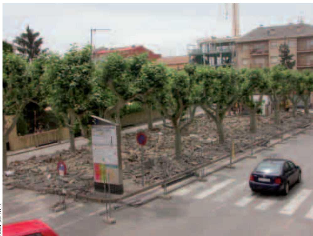
Les obres del Pou van generar polèmica.
