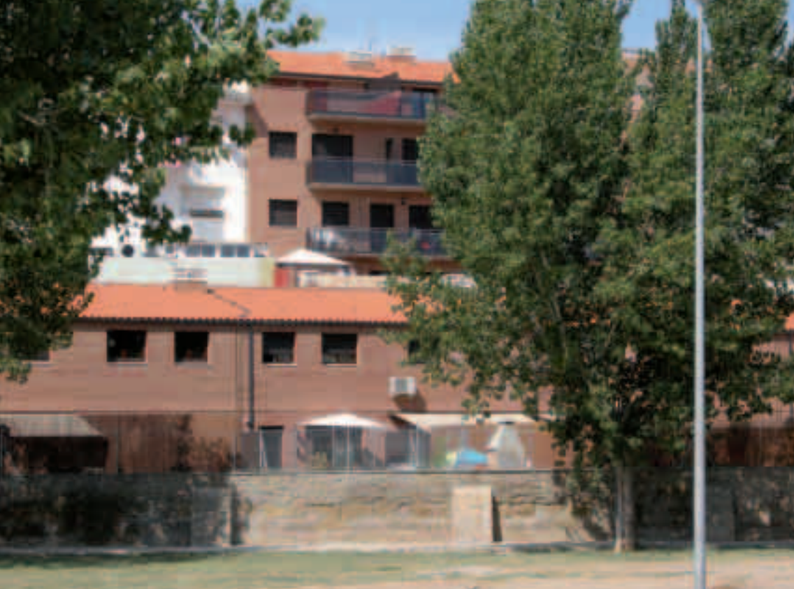
Cases adossades darrere l'edifici de l'avinguda de Marià Jolonch.
