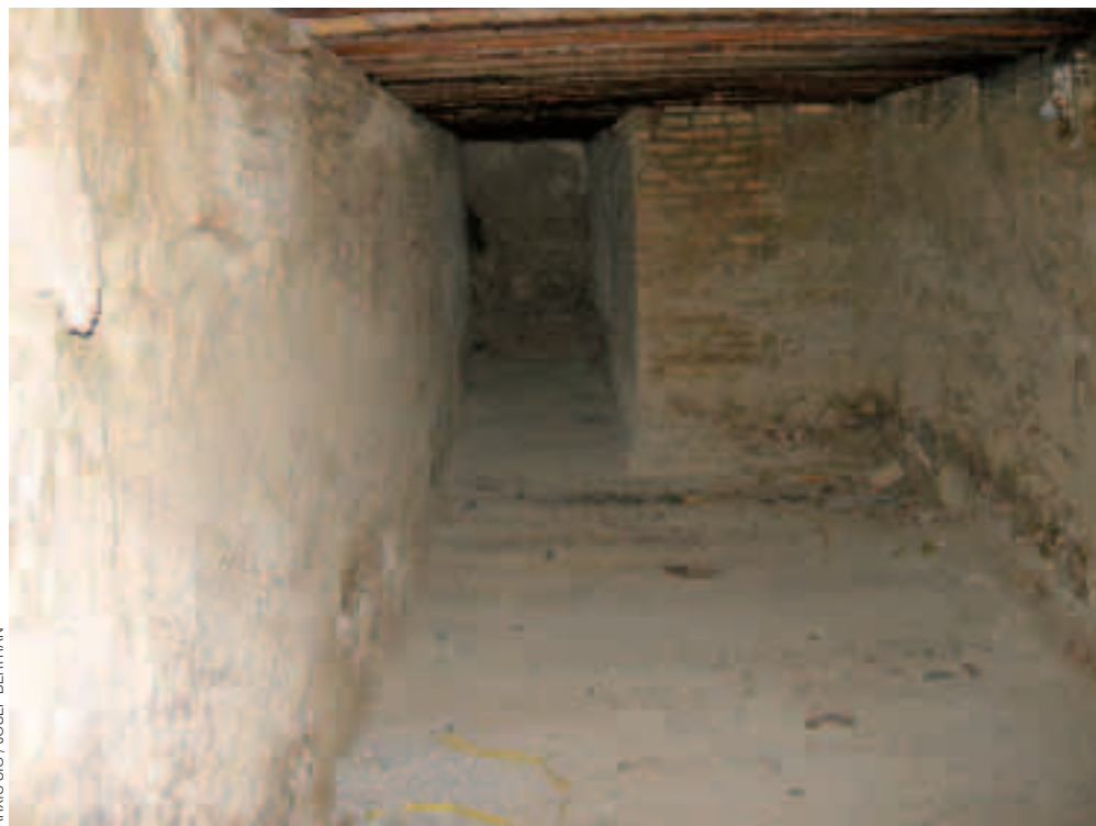
Interior del refugi de l'església, que ara està en procés de restauració.
