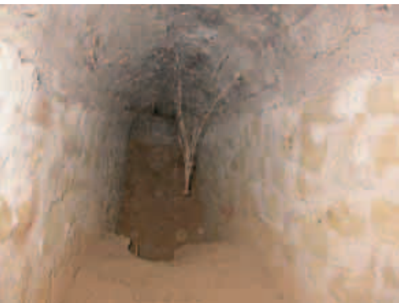
Interior del refugi de l'aeròdrom dels Salats.
