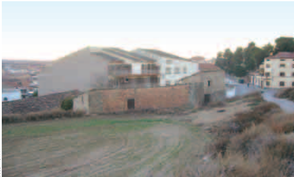
Era de "cal Petitó" on tenien instal·lada la central de telecomunicacions.
