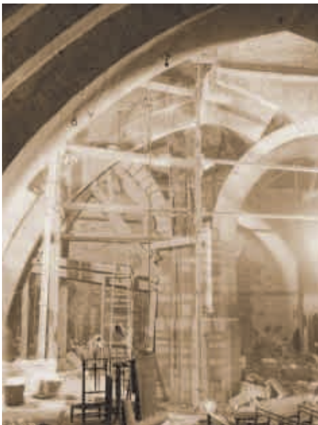
Fase de reconstrucció d'un pilar. 1953.
