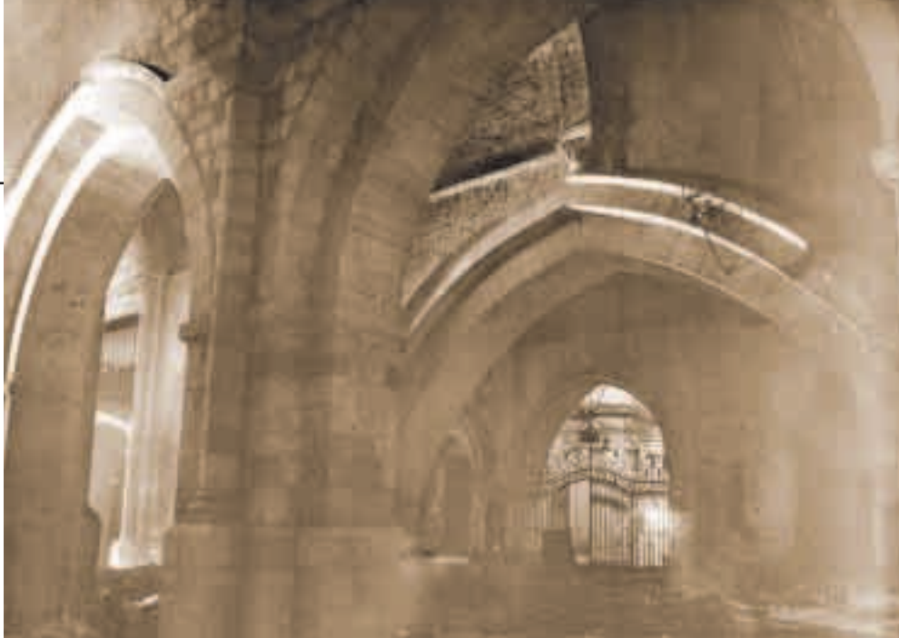
Vista interior després de la reconstrucció d'un pilar de l'església. 1953.
