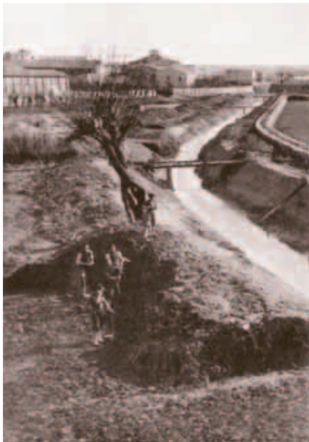
Obres de la canalització. En la imatge es poden veure diverses passarel·les que es feien servir per anar d'una banda a l'altra del riu.
