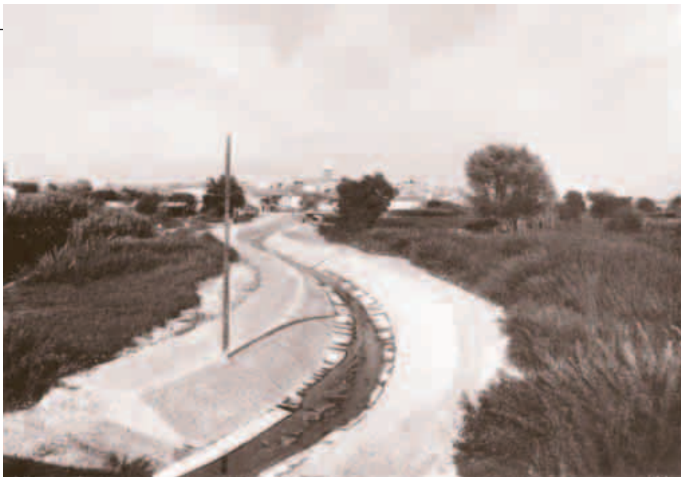
Dues imatges amb les obres acabades. A dalt, una vista des del pont de Ferro. A l'esquerra, el riu sota el pont romànic amb l'ull dret tapat.
