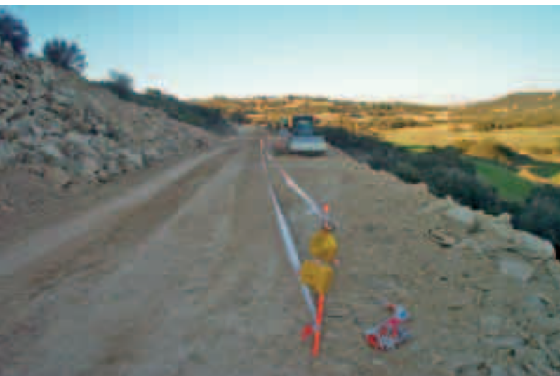
Les obres afecten prop de vuit quilòmetres.
