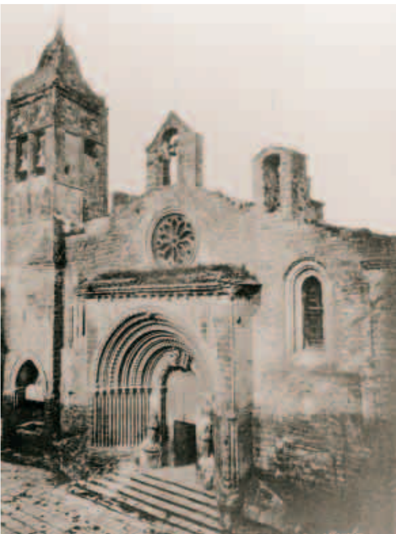
Façana principal de l'església d'Agramunt i del campanar feta abans de l'any 1883. Es poden veure les dues campanes grosses (la de Nostre Senyor i la de l'Assumpta) als finestrals que donen a la plaça. Al damunt de la rosassa una petita espadanya amb la campana petita, la del Perduts. Els finestrals del campanar que donen al migdia, un estava tapiat i l'altre només tenia una petita obertura a la part superior. Damunt del pis de les campanes es pot veure el mur que servia de parapet a qui vigilés des del campanar.
