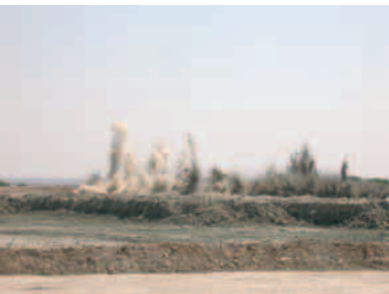
Moment d'una l'explosió efectuada amb barrinades.
