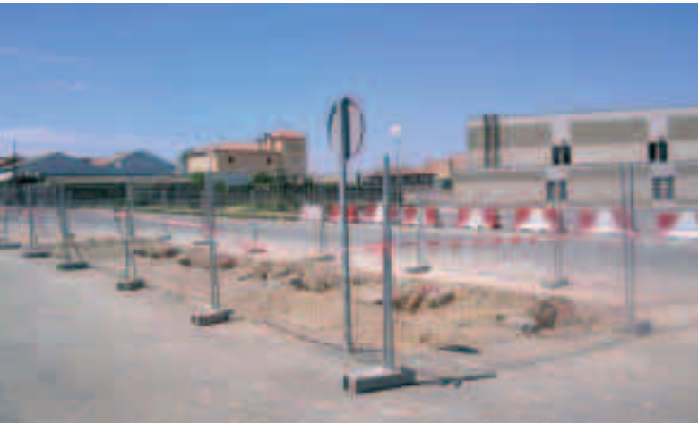
Obres a la nova estació d'autobusos.
