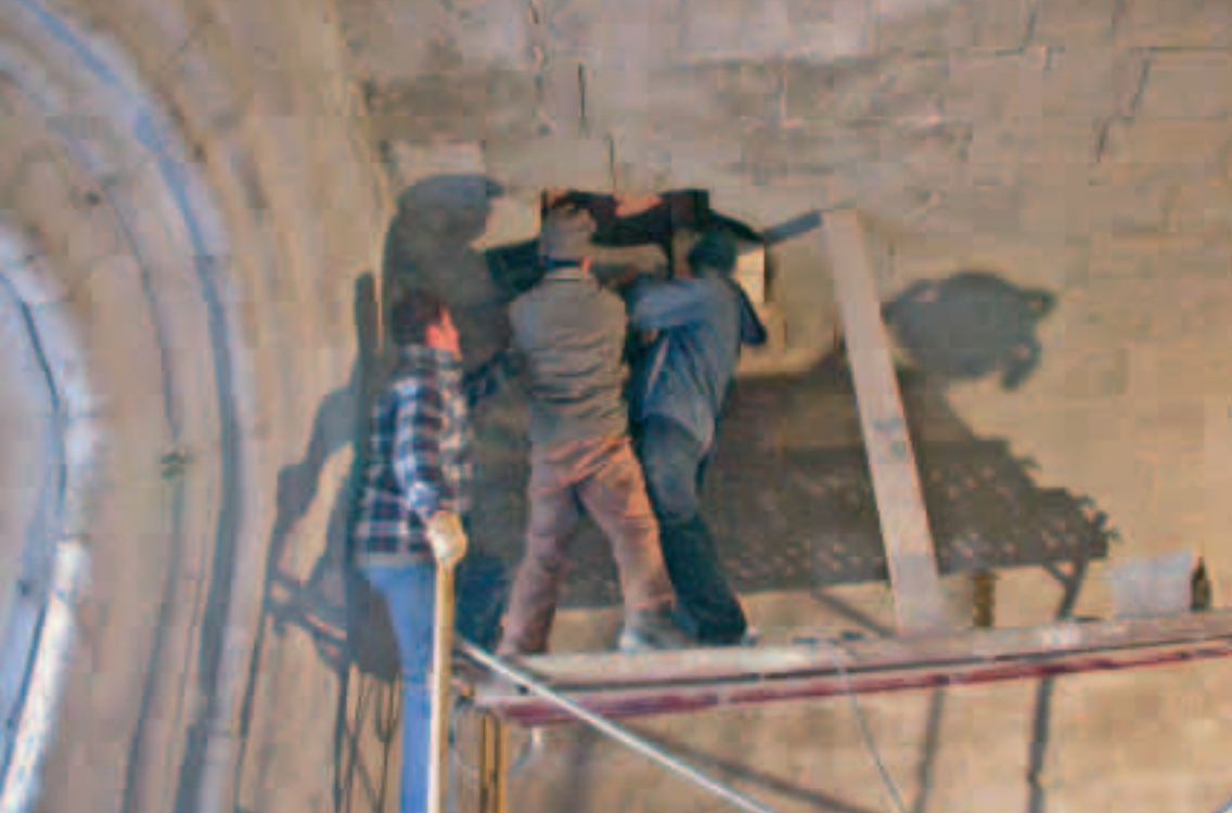
Tres operaris dalt d'una bastida efectuant les tasques de restauració.
