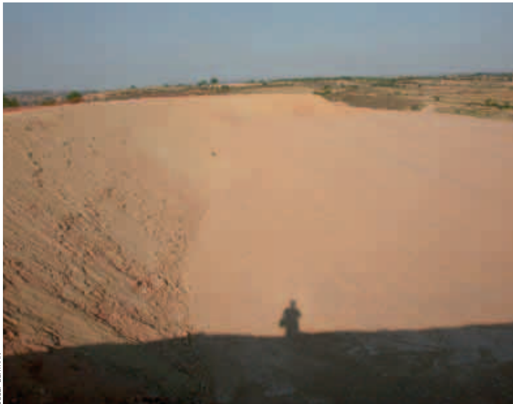
Moviment de terres per ubicar-hi la nova subestació elèctrica.
