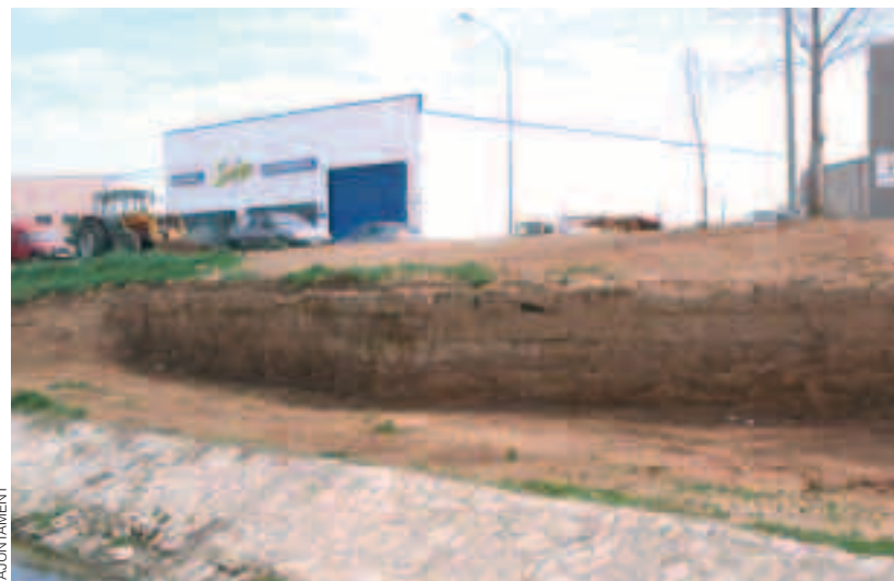
Recuperació marge sud del riu Sió en el tram proper al pont de la carretera de Cervera.
