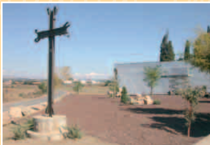
La coincidència del dia de Tots Sants en dilluns va fer que durant tot el cap de setmana el cementiri fos molt concorregut. Els visitants van poder veure l'enjardinament de l'entrada i les obres de construcció d'una nova galeria de nínxols en el tercer recinte.
