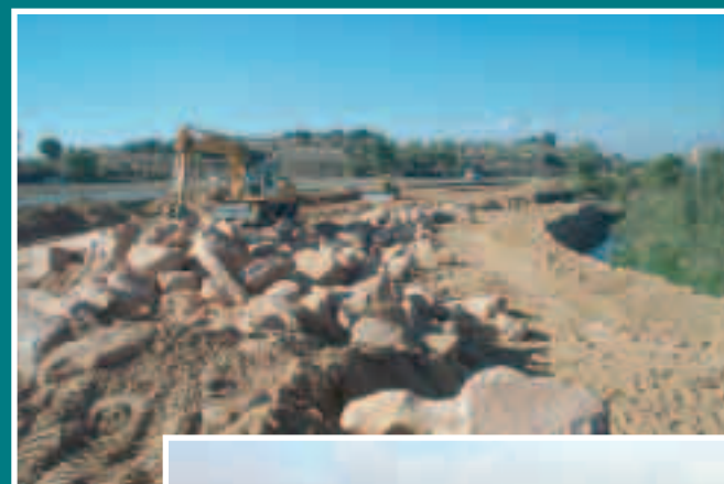
El Sió es canalitza amb grans blocs de pedra.
