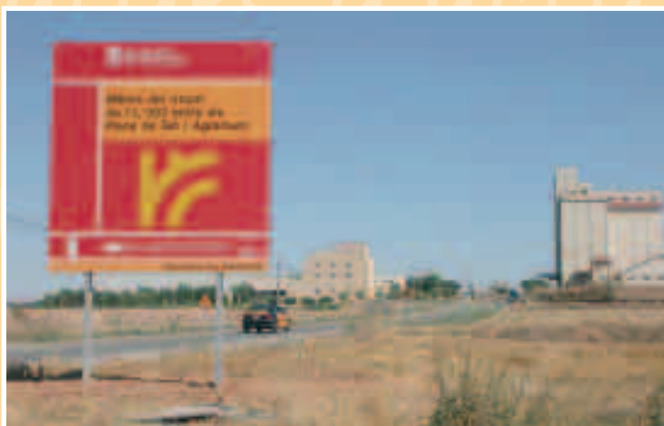
A primers d'agost, la Generalitat va posar aquest rètol a la sortida de la Vila en direcció Cervera anunciant les obres que es fan a la carretera L-303. Primer es van començar en el tram entre Cervera i la cruïlla dels quatre camins, i ara ja es treballa fins al pont del Sió.
