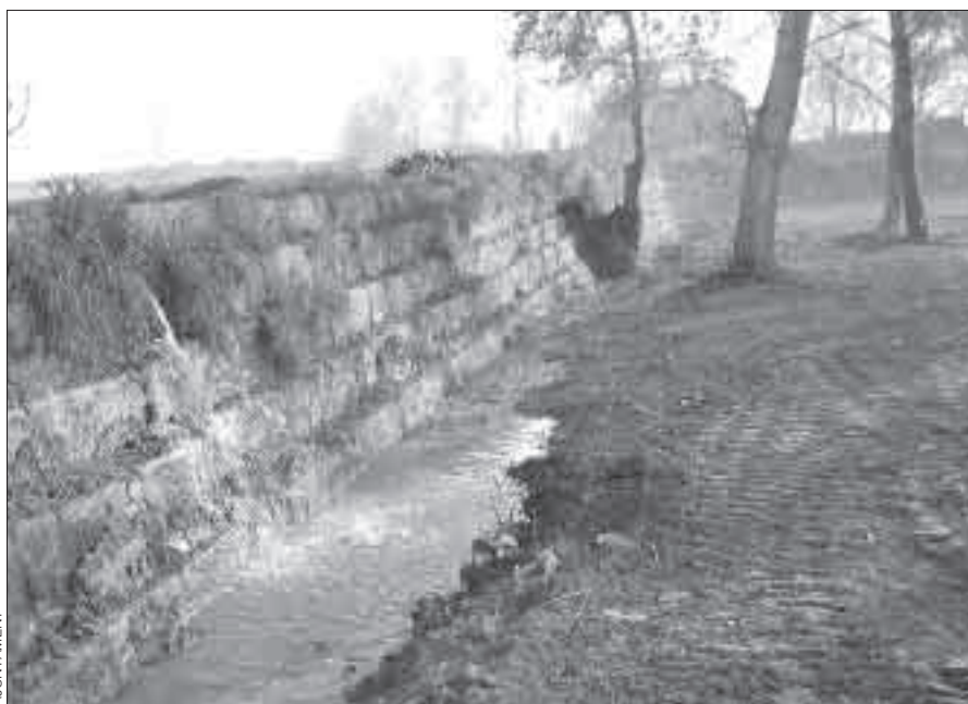
Dic a l'alçada del Pont de Ferro.
