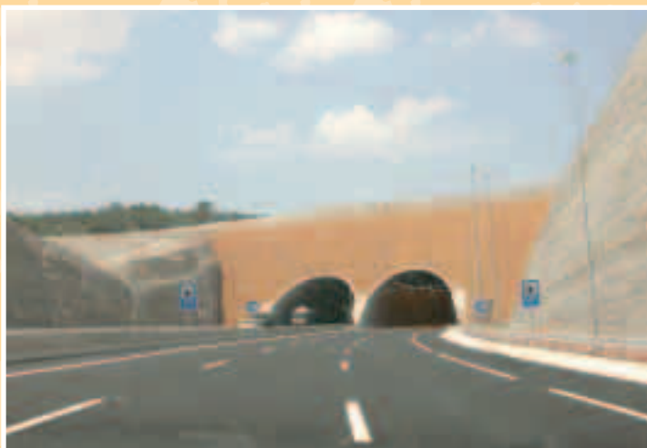
Des del dia 29 de juliol, ja es pot anar fins a Barcelona en autovia, des de Tàrrrega o de Cervera. Per arribar a la capital de la Segarra encara hem de patir una carretera molt deficiente, actualment en obres.
