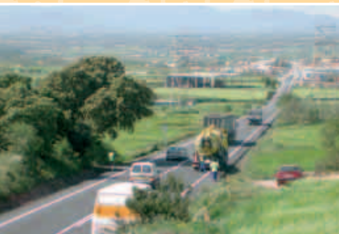
Després de mesos de treballs, amb les corresponents retencions de trànsit, s'han acabat les obres de millora de la carretera de Tàrrega. Essencialment s'ha renovat el ferm, però no s'ha actuat en la perillosa corba de Claravalls, amb nul·la visibilitat i canvi de rasant.
