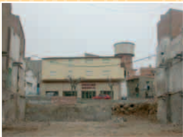
L'enderrocament d'edificis ens dona, temporalment, perspectives noves d'indrets coneguts. En aquest cas podem veure el Castell des de l'avinguda de Marià Jolnoch i per sobre el carrer del Control. És una imatge per al record.
