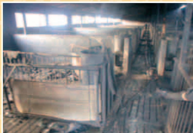
Una granja, situada al costat del cementiri de Puigverd, es va incendiar a primera hora del matí del dia 23 de gener. La nau era buida i el foc únicament afecta les instal·lacions interiors i no a l'estructura de l'edifici. Sembla que la causa va ser el contacte de la flama d'un bufador amb el gas que genera el purí acumulat.
