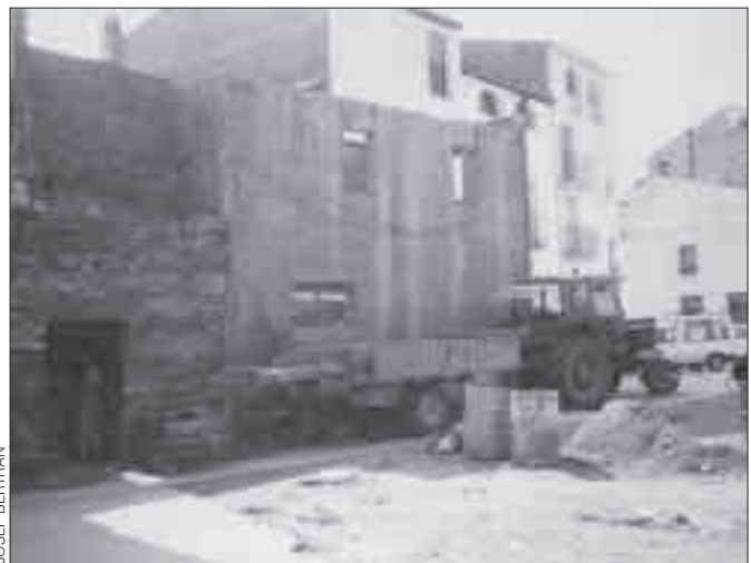
Setembre de 1994, obres al Pardal 2.
