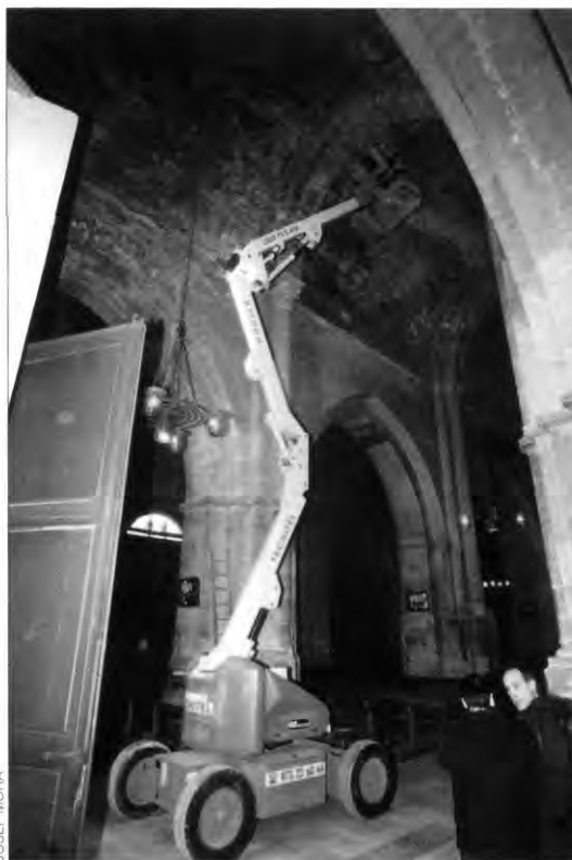
Procés de recollida de mostres del morter de la volta per analitzar la composició.
