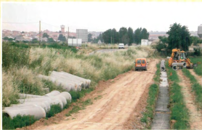
La Generalitat va començar, durant el mes de maig, les obres de construcció de la variant de la C-14, que va quedar pendent quan es va millorar la resta de la via, entre Agramunt i Artesa.
