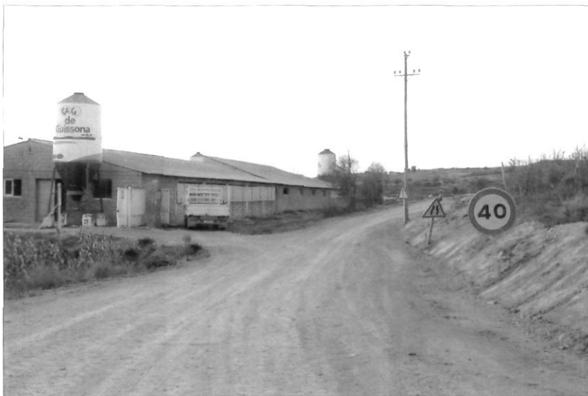
El camí entre Almenara i la Fuliola està en obres.
