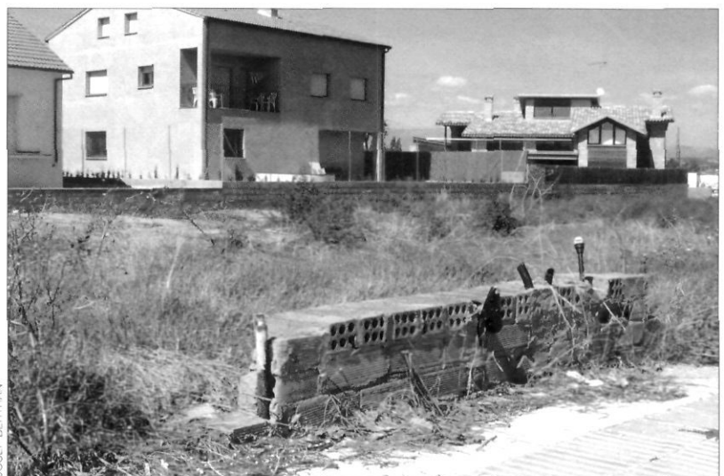
La manipulació dels tubs de gas va motivar la fuga.
