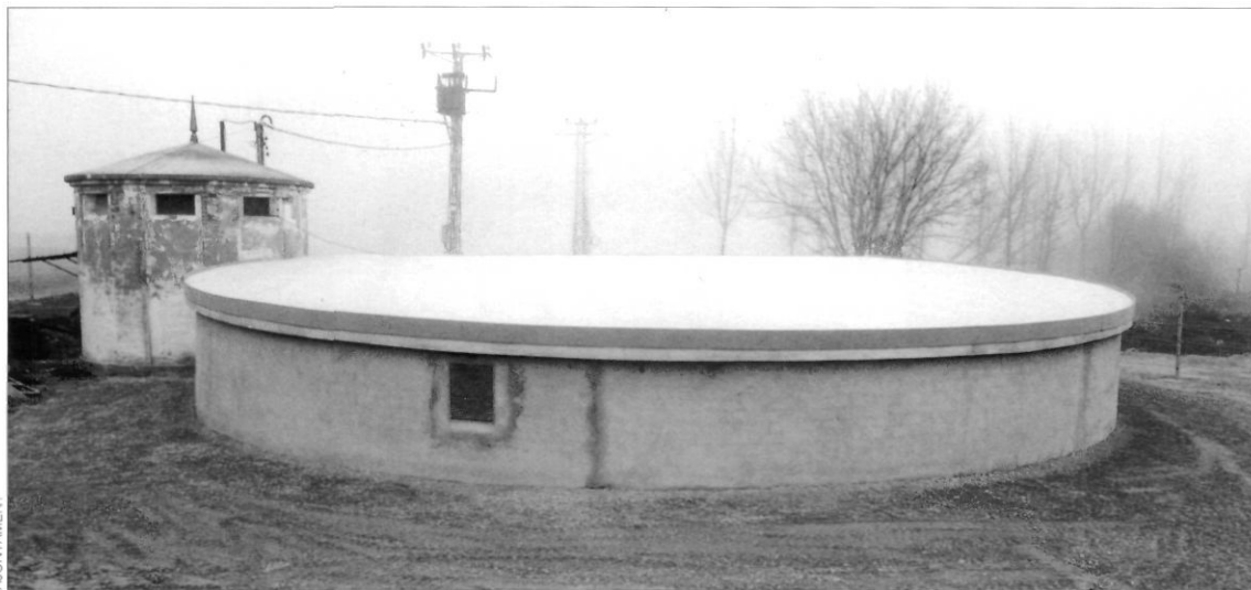
Dipòsit de captació d'aigua de Montclar. Obra finalitzada.
