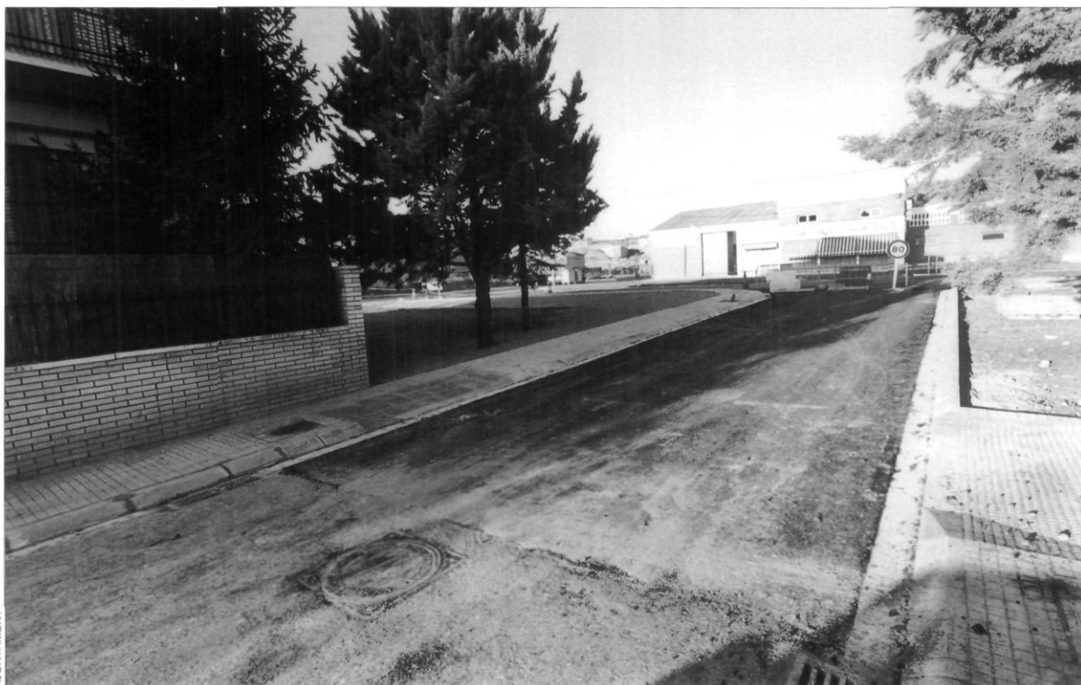
Arranjament paviment carrer Màrius Torres fins la L-303.
