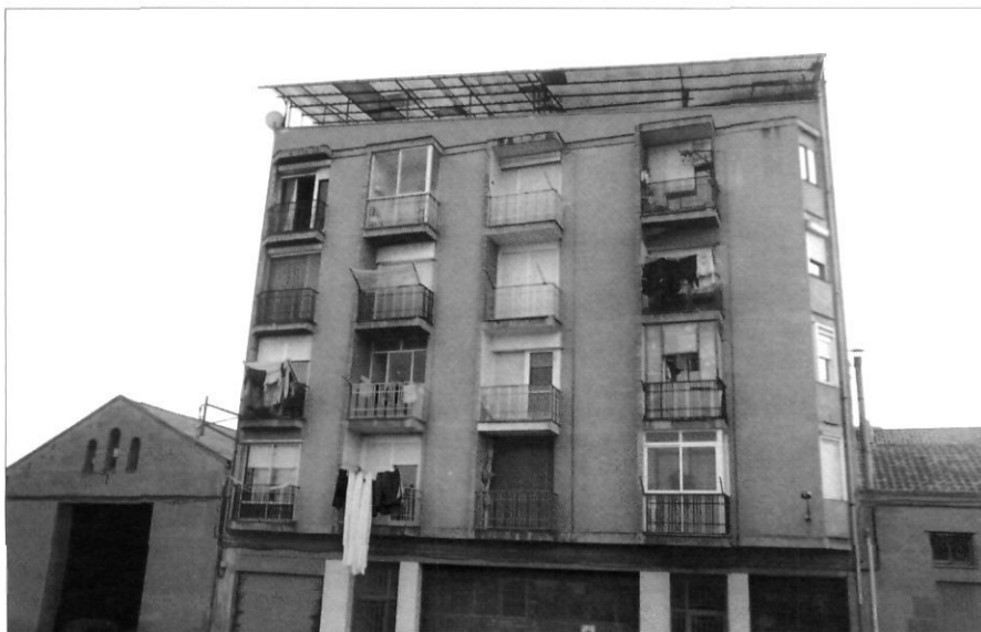
Les obres afecten l'últim pis de l'edifici.
