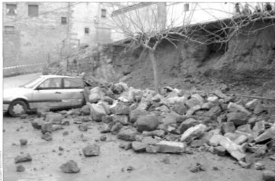
La muralla del Botador s'haurà de refer.
