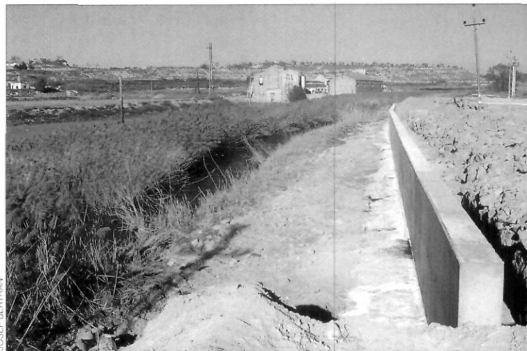
Al marge esquerra del Sió, abans del pont de Puigverd, s'ha construït un mur de contenció.
