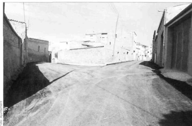
Arranjament del paviment Costa de la Fassina - C. de la Bassota.
