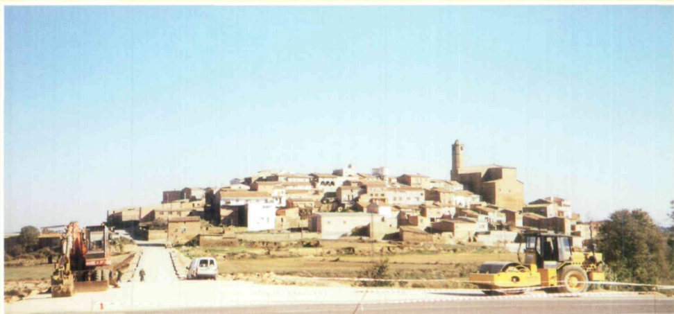
El poble de Puigverd d'Agramunt ja té un nou accés des de la carretera, una vegada construït el nou pont sobre el Sió.
