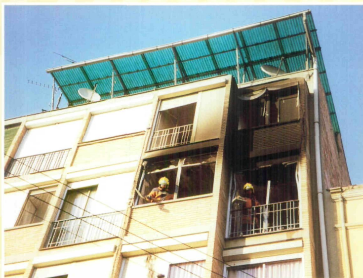
Un incendi va afectar greument un pis situat a l'avinguda de Marià Jolonch. La intervenció dels bombers va evitar que aquest incendi es propagués a la resta de l'habitatge i al pis superior, tot i l'aparatositat de la imatge.
