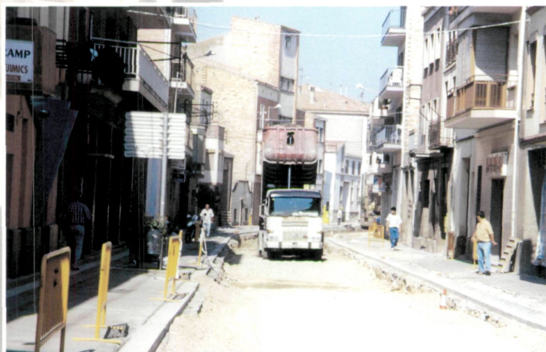
A l'avinguda M. Jolonch hi va haver més feina. El sòl era "contaminat" i es van haver d'estendre capes de grava per sota.
