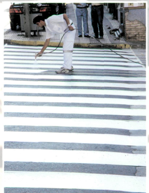
Les obres es donen per acabades amb la pintura dels senyals horitzontals.
