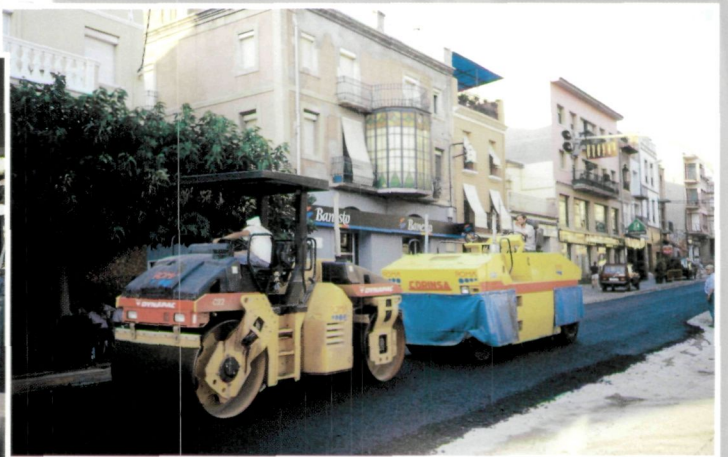
Les noves capes de quitrà són ràpidament presades amb unes potents piconadores.
