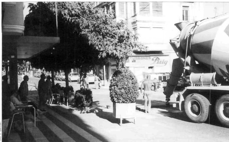
Les obres a la carretera van començar el dia 5 de juliol.
