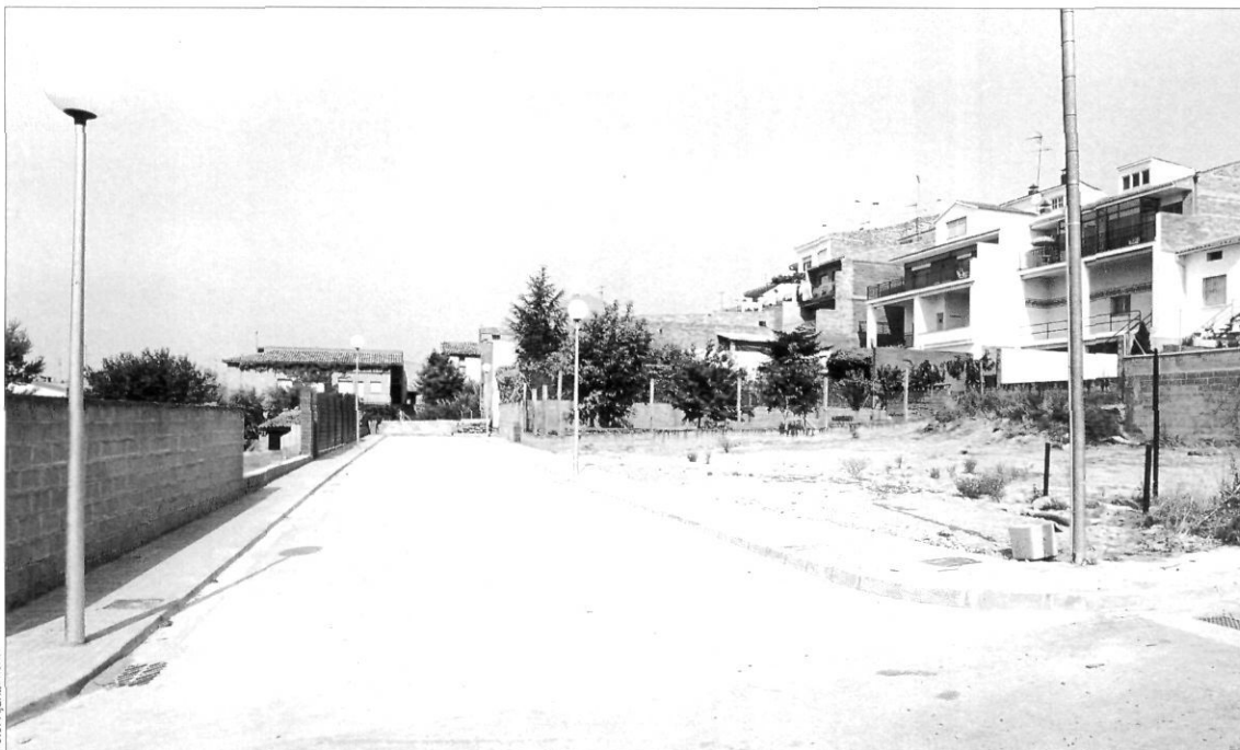
Urbanització carrer de la Miranda.
