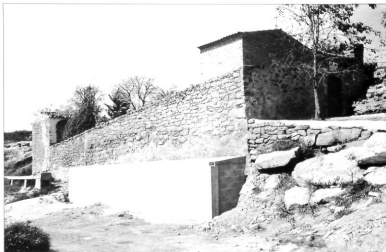
Mur de contenció cementiri de les Puelles.
