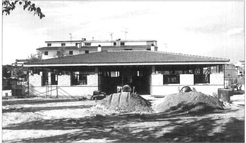
Obres edifici nou guarderia municipal.
