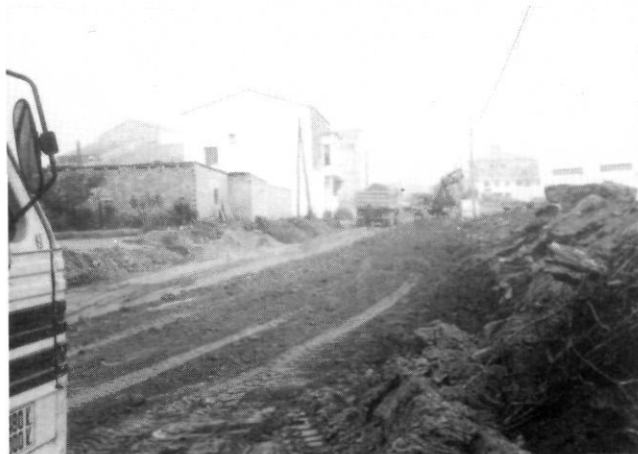
Les obres d'acondiament de l'entrada a la vila per la carretera de Balaguer, s'estan duent a bon ritme. (Foto: J. Bertran)
