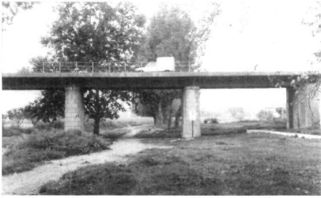
Pont Nou de la carretera de Tàrrega.
