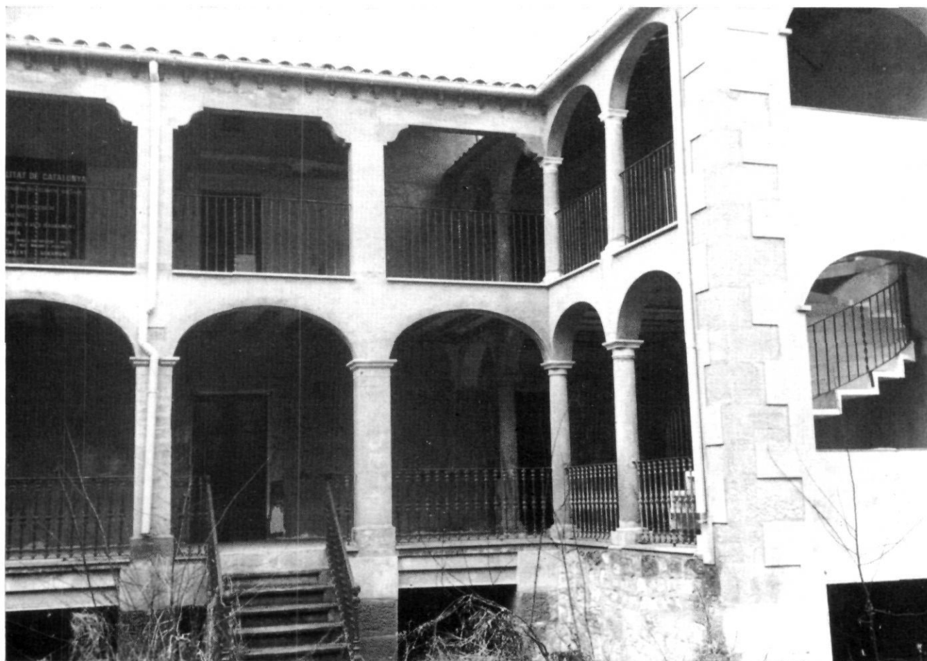
Galeria, del mateix edifici de Cal Mas Vell, que ha estat restaurada.
