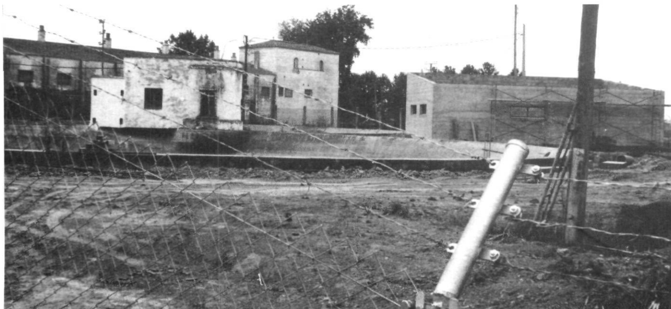
Vista parcial de les obres de construcció de la Depuradora d'Aigua Potable
