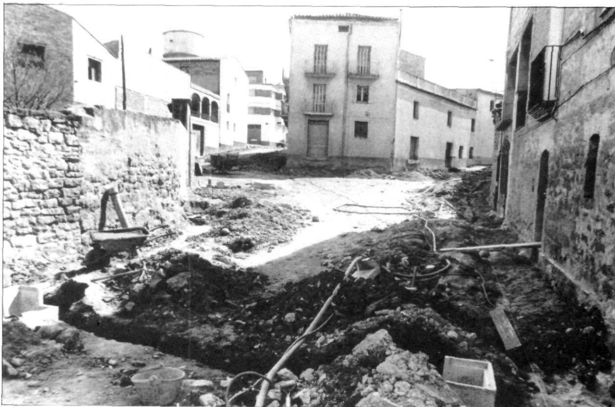
VISTA PARCIAL DE LES OBRES DEL CARRER DEL FIRAL
