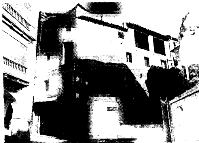
El patrimoni municipal es veurà incrementat amb l'adquisició d'aquest immoble, adossat per la cara sud a Ca la Vila.
