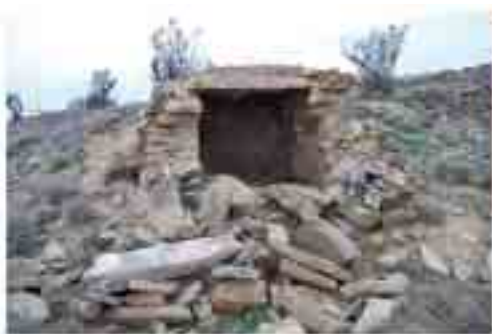
Restauració d'una cabana de pedra seca a la Serra de Castellserà.
