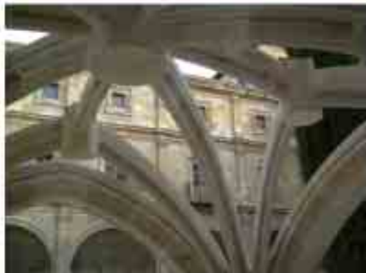
Volta de creueria realitzada a l'escola de picapedrers de León, any 2002.
