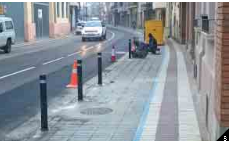
Canviant la resta dels blocs de formigó pels pilons flexibles.
