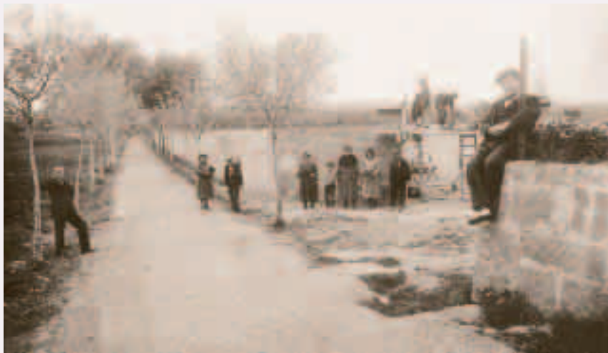
Construcció del camp de futbol al Passeig nou.
